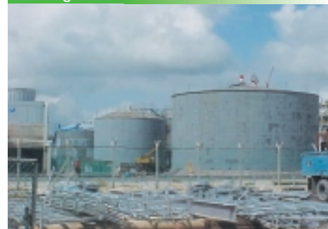
「進行中の現地組みタンク工事」
