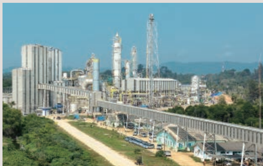
完成プラント
