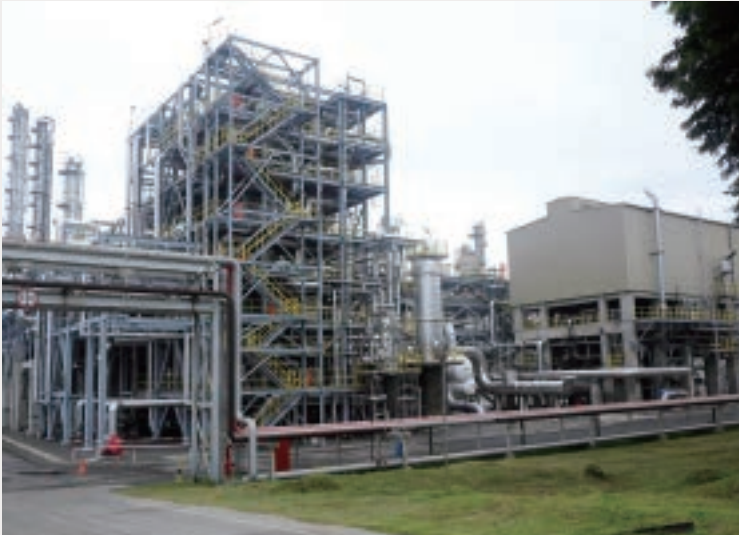
完成プラント
