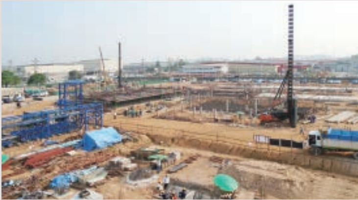
2015年2月に着工した1件目の建設現場
