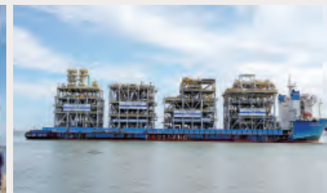
インテグレーションヤードに搬送される4モジュール
