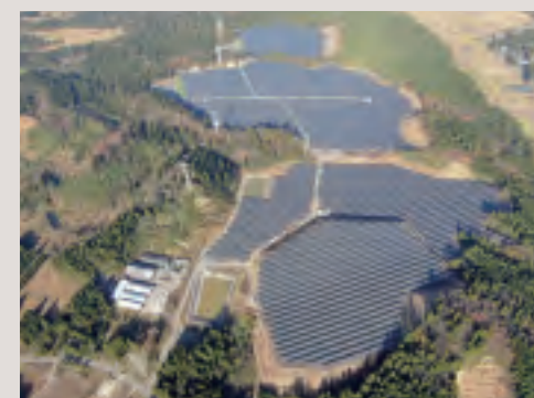
太陽光発電所
