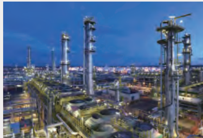
ガソリン生産設備
