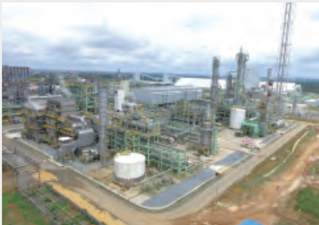
第1製造設備のプラント全景
