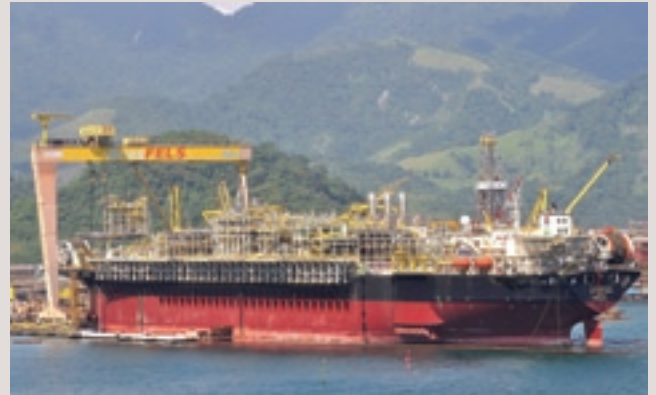
ヤードでインテグレーション作業中のFPSO
