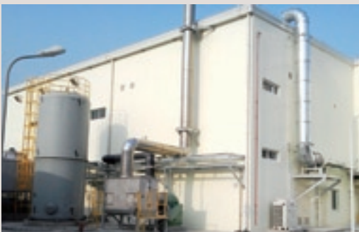
2012年12月に完成した中国の工場
