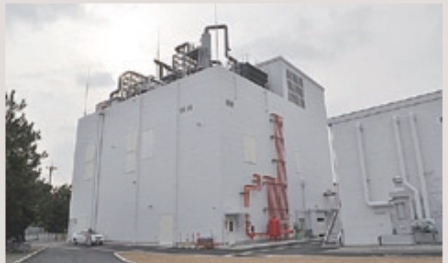
高生理活性原薬製造棟
