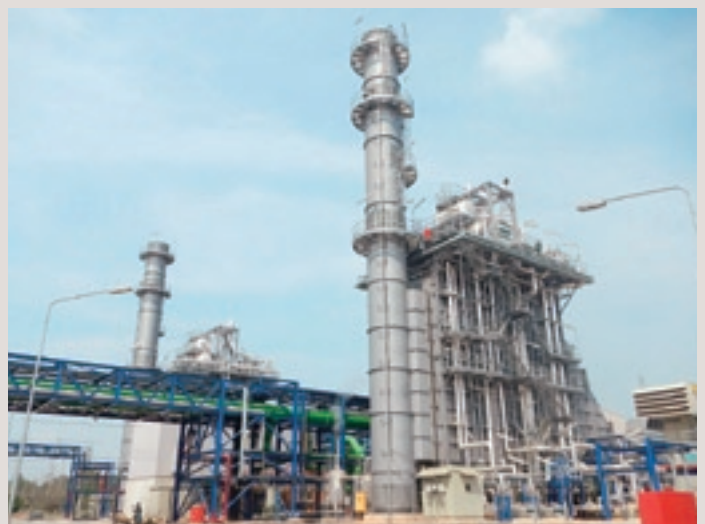
最初に稼働したGKP1発電所
