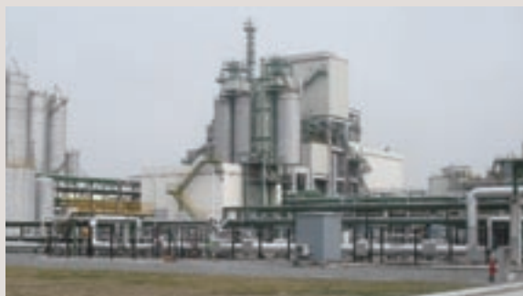
完成プラント全景
