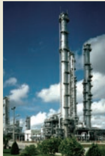
タイ ガス分離プラント (1982)
