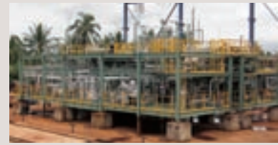
タイで製造されたGTLモジュール
