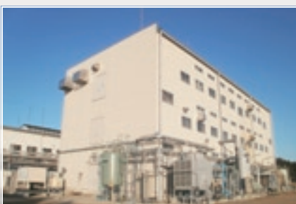
完成した医薬品原薬製造設備
