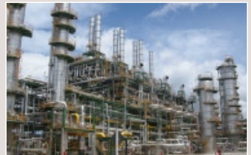
引渡しを受けたエチレンプラント
