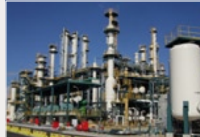
完成した残油流動接触分解設備
