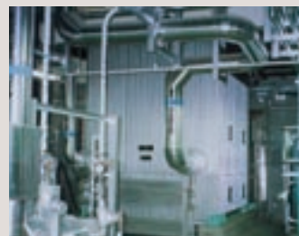
10MW電気ボイラー-蒸気ドラム▲ 10MW電気ボイラー-蒸気発生器▶
