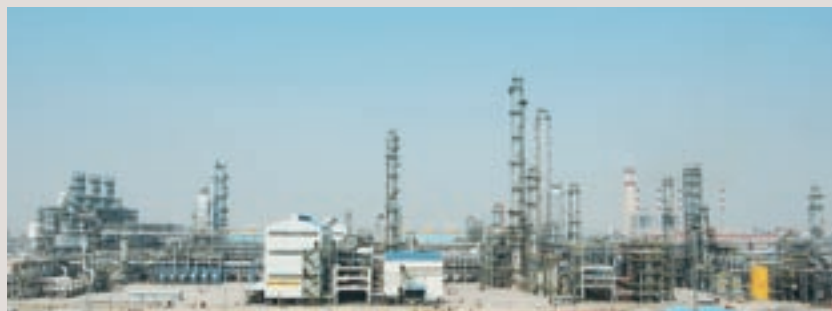
完成したエチレンプラント
