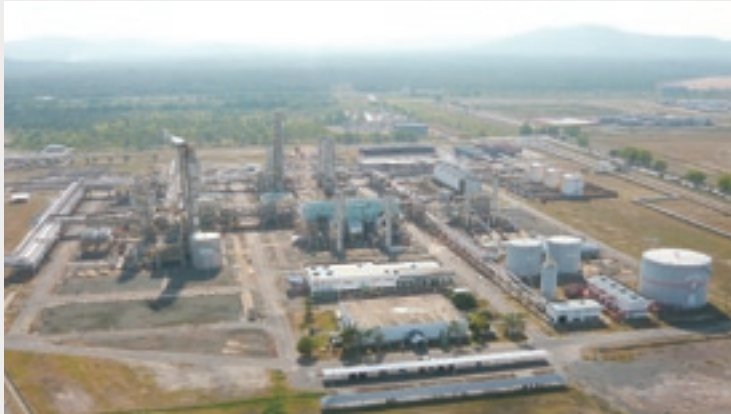
近代化が完了したプラント
