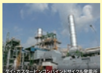
タイ・ガスタービンコンバインドサイクル発電所
