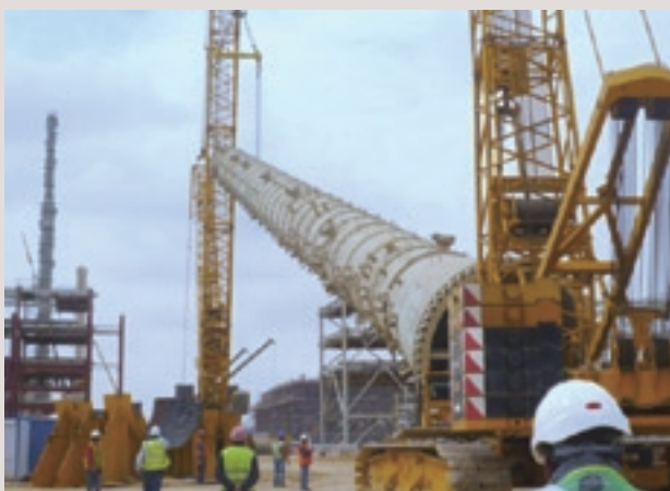
エチレンフラクシオネーター据え付け工事
