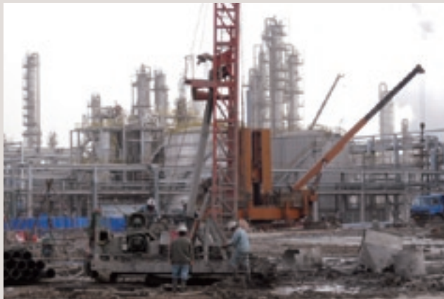
IPS-IIプロジェクト建設現場
