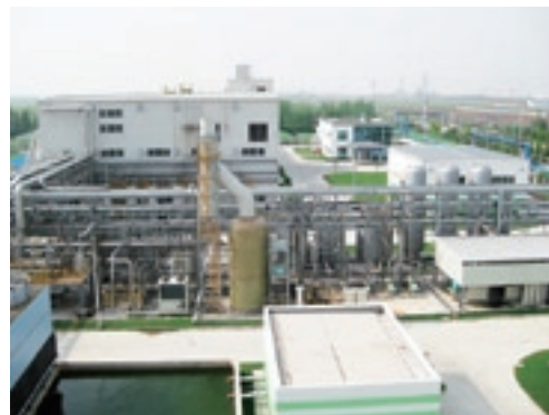
南通住友電木有限公司 フェノール樹脂製造プラント
