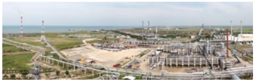
バロンガン製油所建設現場
