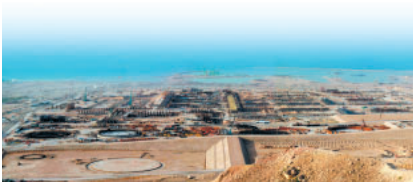
イラン・サウスパース建設サイト
