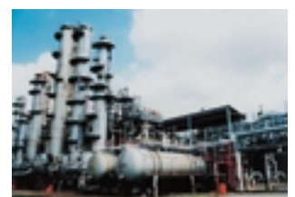
既設のVCMプラント
