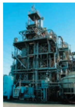
ICFGパイロット設備 写真：㈱荏原製作所提供
