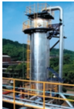
中国石化集団四川維尼綸廠向けNo.2 メタノールプラント MRF-Z® リアクター
