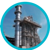
タイ ガス火力発電
