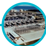
ブルネイ ガス火力発電
