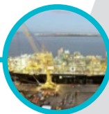
ブラジル FPSO
