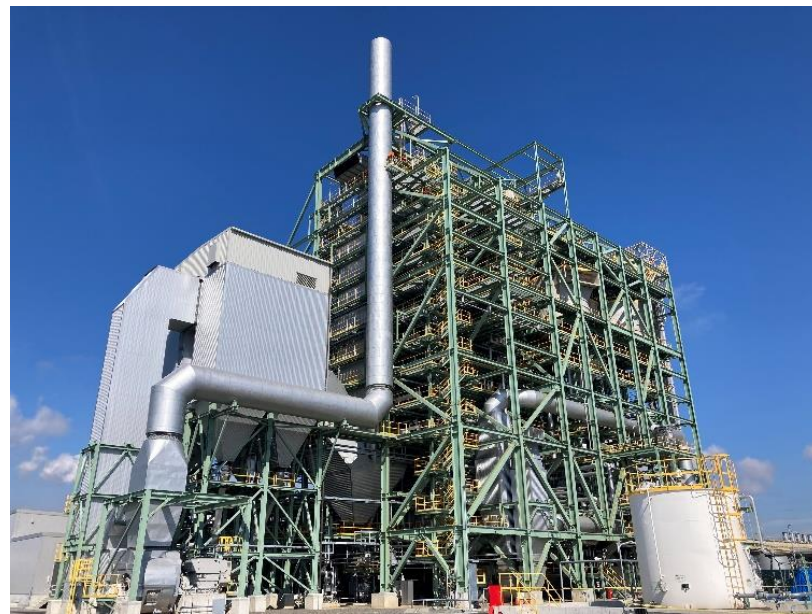
Biomass power plant (Kamisu, Ibaraki)
