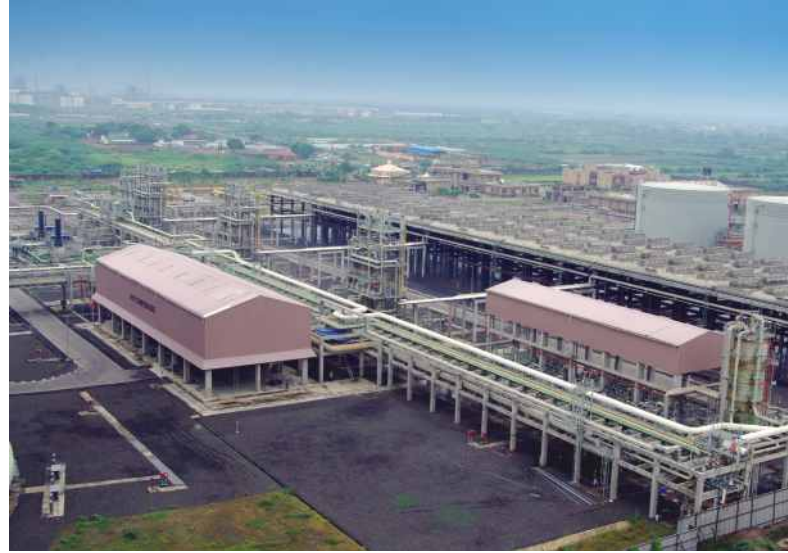
Regassification Facility at LNG Terminal, Dahej Client : Petronet LNG Ltd.
